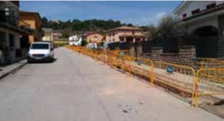
Portada d'aigües en el tram del Carrer Barcelona
